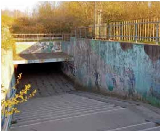
Der bliver lavet en ny flad rampe ved tunnelen under Østerby Alle.
