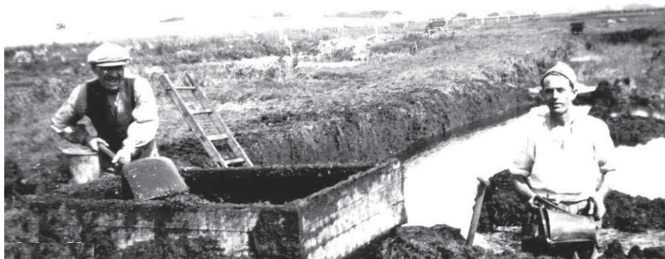
Tørvegravning ved Tranbjerg Mose (området ved Tranbjerg Sø), ca. 1944. Personerne er Jens Godsk og Villy Rasmussen.
