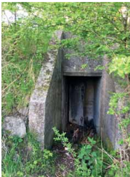
Indgangen til dækningsgraven på hjørnet af Sletvej og Ellemosevej maj 2021. I dag er der sat en lås for døren til rummet.
