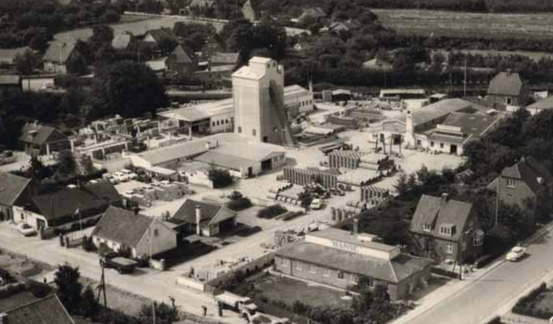
Cementfabrikken 1967. Den høje blandestation dominerer billedet, og bag den er elementhallen. I forgrunden ses legetøjsfabrikken Hanse. Sylvester Luftfoto
