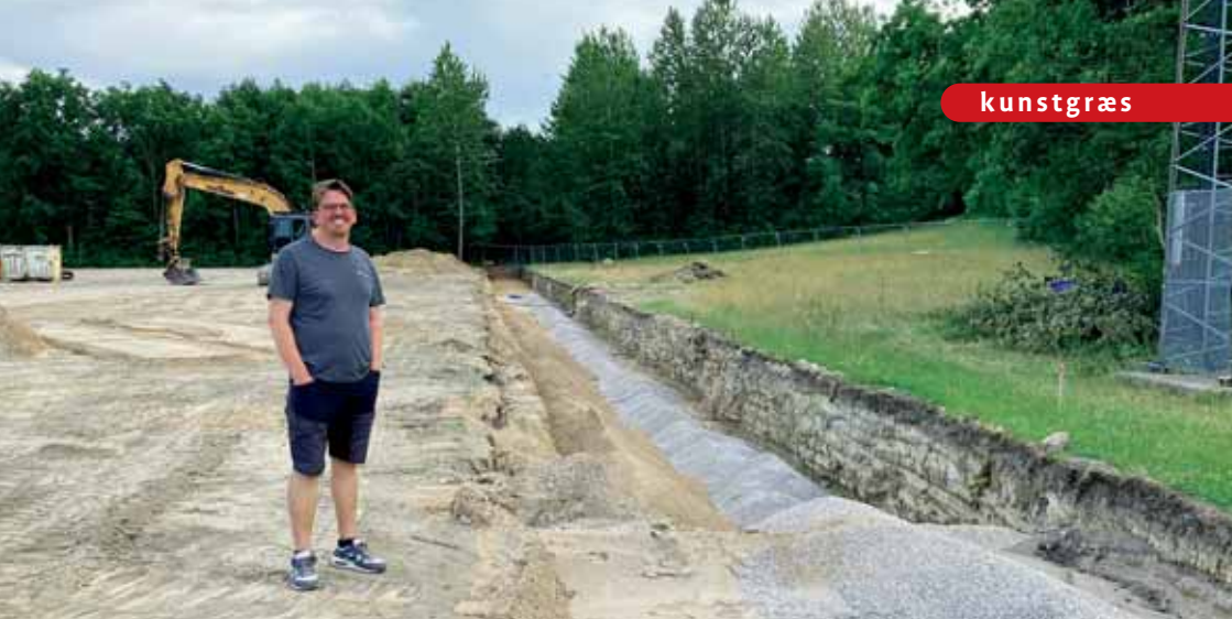
Morten Mølgaard følger nøje etableringen af kunstgræsbanen. Udgravningen i kanten af banen er til faskiner, der skal opsamle og rense regnvandet.
