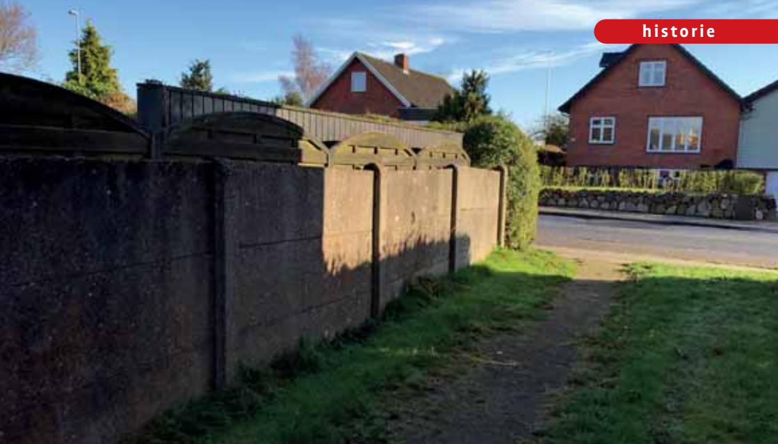
Betonplankeværket der adskiller boligerne ved Hammervænget og Gartnervængets haver. Fotograferet ud mod Tranbjerg Hovedgade november 2024.
