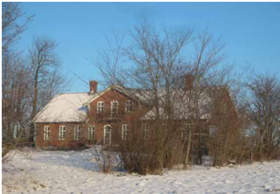
Ovesmindes stuehus fra 1892 fotograferet fra havesiden i januar 2016. Den store kvist er bygget til senere, måske ca. 1930.
